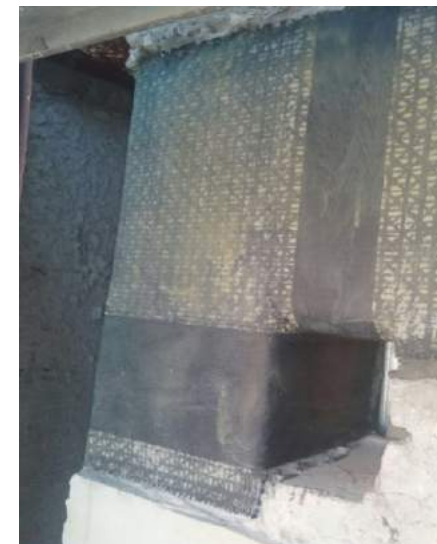
CONFINAMENTO NODI TRAVE-PILASTRO
