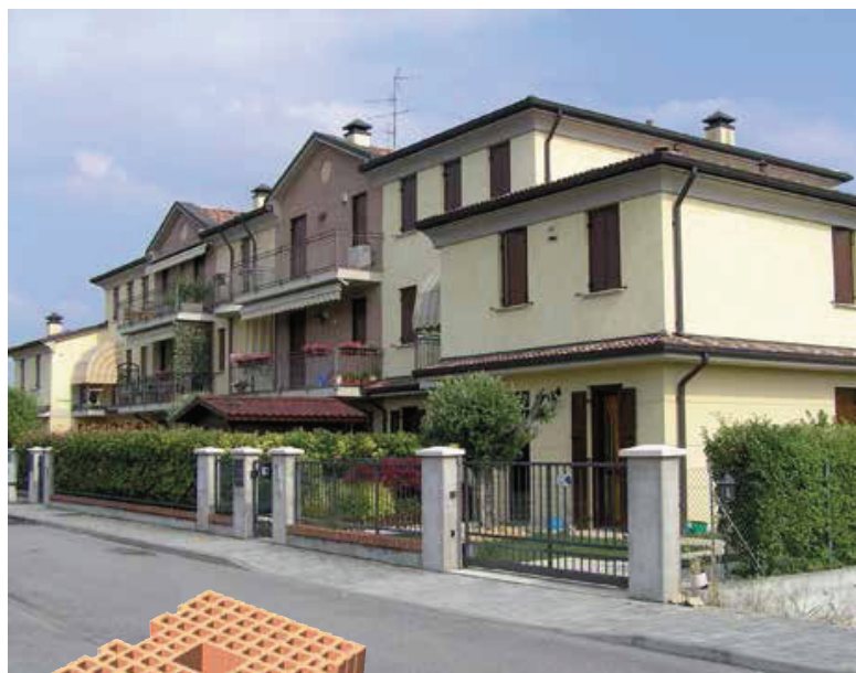
Blocco in laterizio P62/30 di CIS EDIL per murature portanti armate e antisismiche. Il complesso residenziale a Mirandola (nella foto) è stato realizzato con il blocco P62/30.
