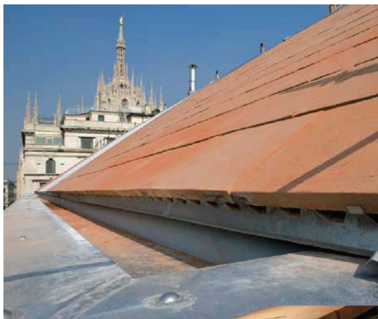
Cotto al Cubo , ultimo nato in casa SANMARCOLAB . Sistema di involucro a secco ventilato con rivestimento di grandi lastre in cotto tradizionale a pasta molle. Impiegato per lo Star Hotel Rosa a Milano.
