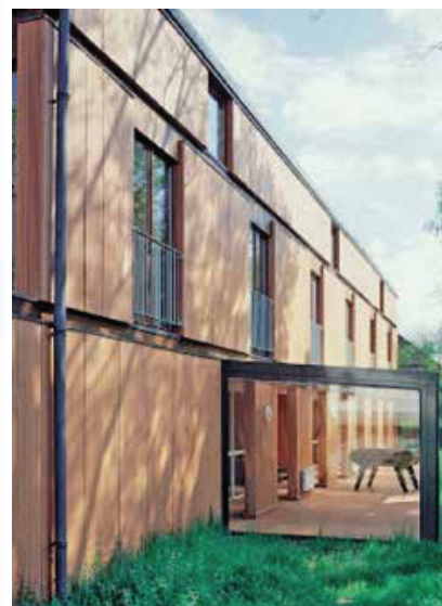
Gli elementi monolitici in laterizio di grandi dimensioni e altezza interpiano consentono di ottenere soluzioni suggestive senza però venire meno alle necessarie prestazioni, come dimostra il Centro di formazione e residenza a Nivillers (F) progettato da Sabri Bendimérad e Pascal Chombart de Lauwe.
