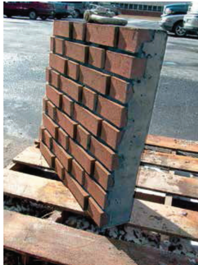
La prefabbricazione come dimostra brillantemente lo studio SHoP di New York, consente di eliminare i consueti errori in fase di esecuzione riducendo, al contempo, i tempi e i costi di realizzazione.
